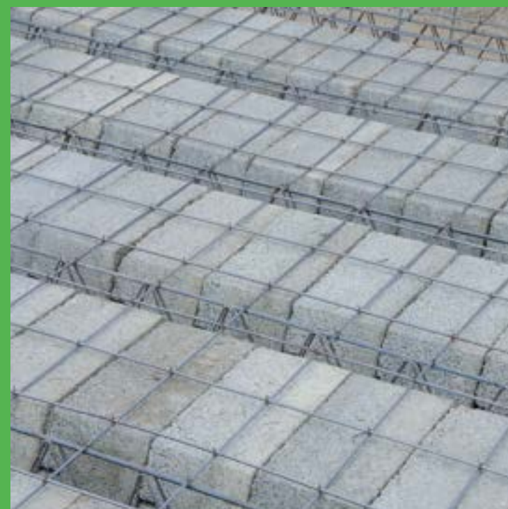
Installation des poutrelles, hourdis et ferrailage dalle de compression
