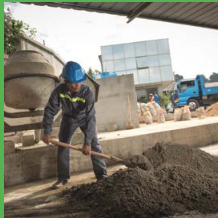
Phase de préparation (dosage, mélange ...)
