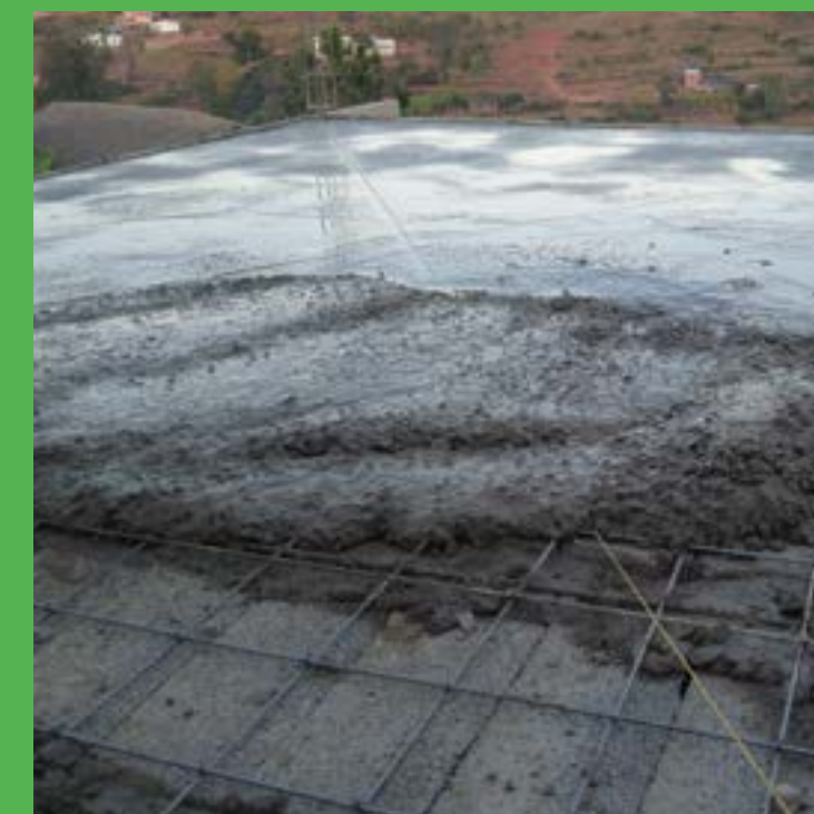
Coulage béton dalle de compression et nervure
