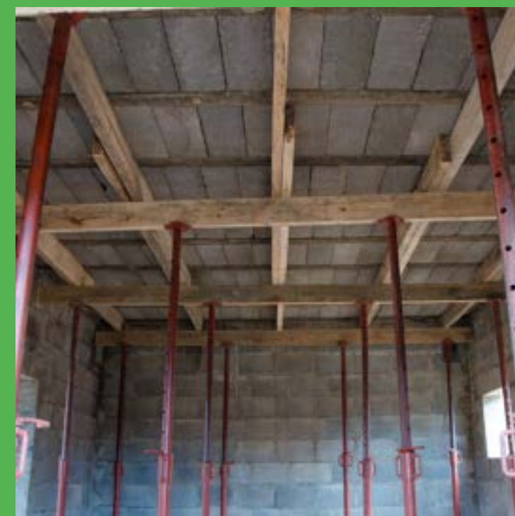
Etayage pour supporter la structure
